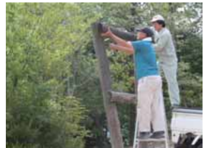
【アスレチック遊具の修理】
