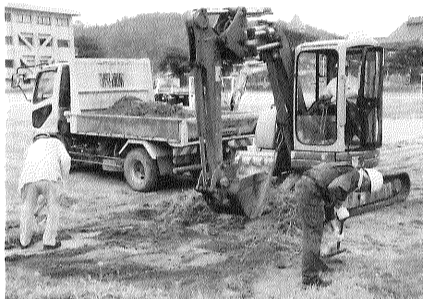
バックホウと手作業でグラウンドを整備(木之本小学校)
