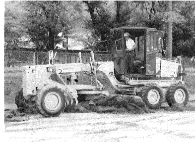
グレーダーでの整地作業(西浅井中学校)
