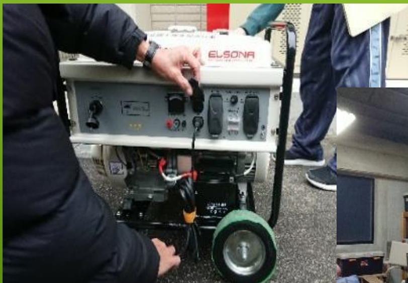
発電機の試運転
