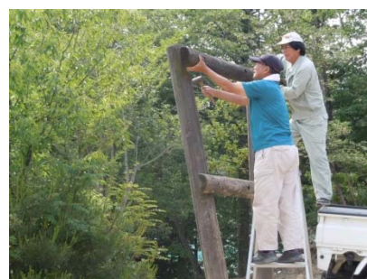
【アスレチック遊具の修理】
