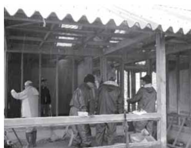
【 飼育小屋解体作業 】
