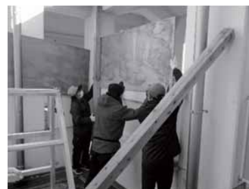
【 渡り廊下風除け設置支援 】
