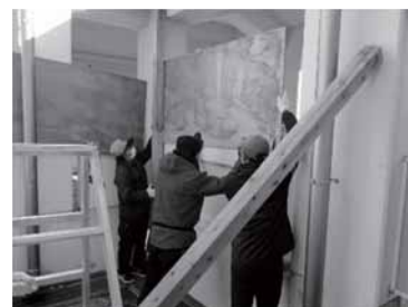
【 渡り廊下風除け設置支援 】
